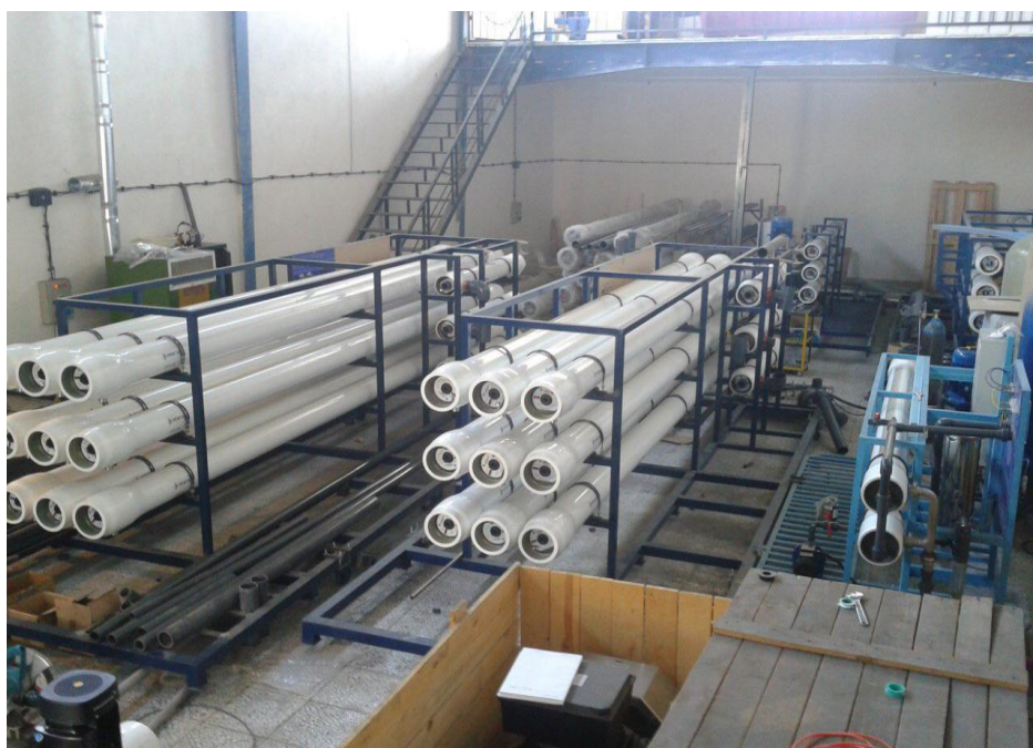
کارگاه ساخت صنعتی شرکت عمران سازان مهاب
